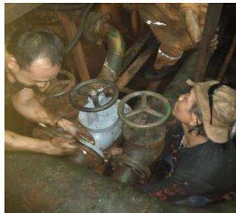
Gambar 2 Perbaikan *Sea Water* pada *Lubricant Oil Cooler*.
