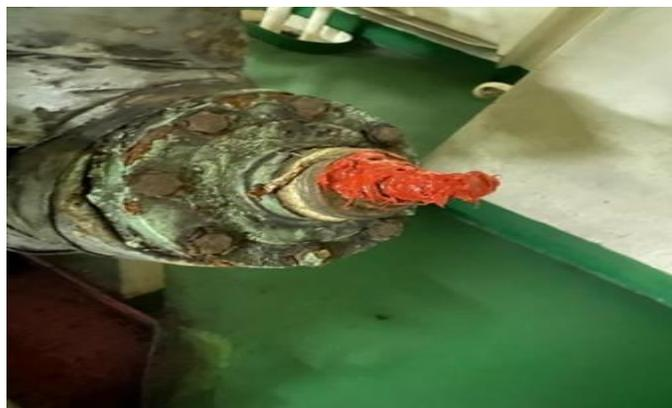
Gambar 1 Hasil penambalan *valve* yang bocor menggunakan *devcon*
