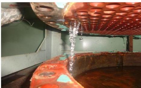
Gambar Kebocoran pada Pipa *Evaporator* FWG
