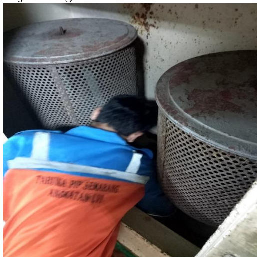
Gambar 1. Proses Pembersihan Filter Udara Hisap
