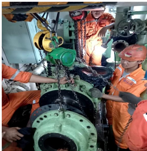
Gambar 2. General overhaul pada cargo compressor
