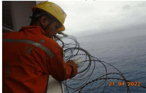
Gambar 1. Merupakan Proses Pemasangan *Razor Wire* yang Berkarat di Atas Kapal MT. B Ocean
